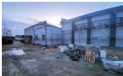
Budowa hali sportowej w Spiach
