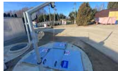
Modernizacja Oczyszczalni Ścieków w Nowym Dzikowcu
