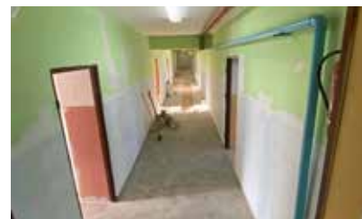
Modernizacja budynku Zespołu Szkół w Dzikowcu
