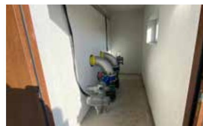
Modernizacja Oczyszczalni Ścieków w Nowym Dzikowcu
