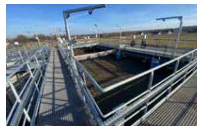
Modernizacja Oczyszczalni Ścieków w Nowym Dzikowcu
